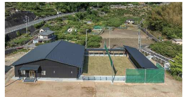
(八幡浜市弓道場外観)
